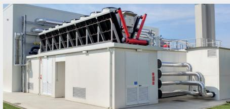
Questo laboratorio è l'ultimo costruito ed è in grado di testare unità con capacità frigorifera fino a 1,5 MW, con un'elevata precisione in un esteso range di condizioni di lavoro che va da -10 a +55 °C, anche per le unità adiabatiche.
