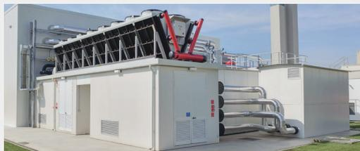
Questo laboratorio è l'ultimo costruito ed è in grado di testare unità con capacità frigorifera fino a 1,5 MW, con un'elevata precisione in un esteso range di condizioni di lavoro che va da -10 a +55 °C, anche per le unità adiabatiche.
