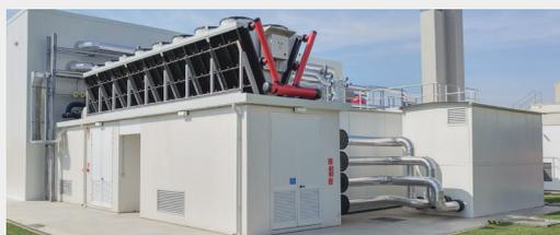
Ce nouveau laboratoire peut tester des unités avec des capacités de refroidissement allant jusqu'à 1,5 MW avec une précision de pointe dans une large gamme de conditions de travail, de -10 °C à +55 °C, et cela également pour des unités adiabatiques.
