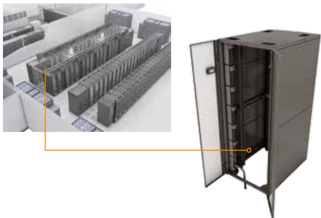
Figura 2. Posizionate sul retro dei rack e rivolte verso il corridoio caldo, le rack PDU possono essere esposte a temperature superiori a 50°C.
