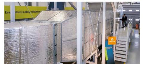
Zona dedicada a probar la innovadora unidad de freecooling Liebert EFC, un sistema de evaporación indirecta altamente eficiente. Los parámetros de prueba incluyen cargas de T1 de hasta 450 kW y un flujo de aire de hasta 120 000 m³ por hora a cualquier temperatura ambiente externa necesaria para simular las condiciones habituales pico presentes en la región EMEA.
