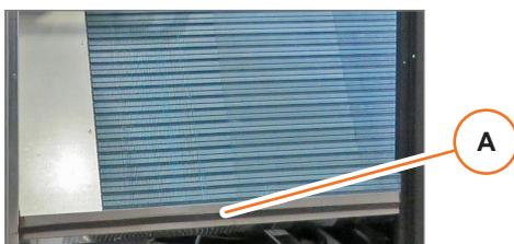
La bandeja [A] recoge el condensado del intercambiador de calor de tubos y aletas para refrigeración.
