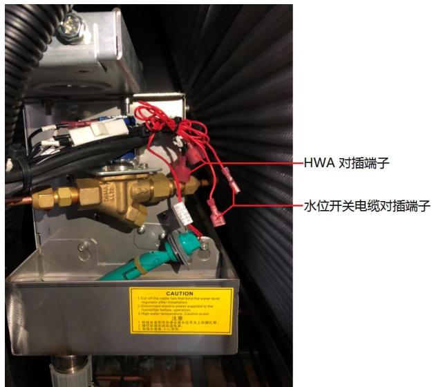
图3-19 高水位检测开关浮杆和 HWA 端子
