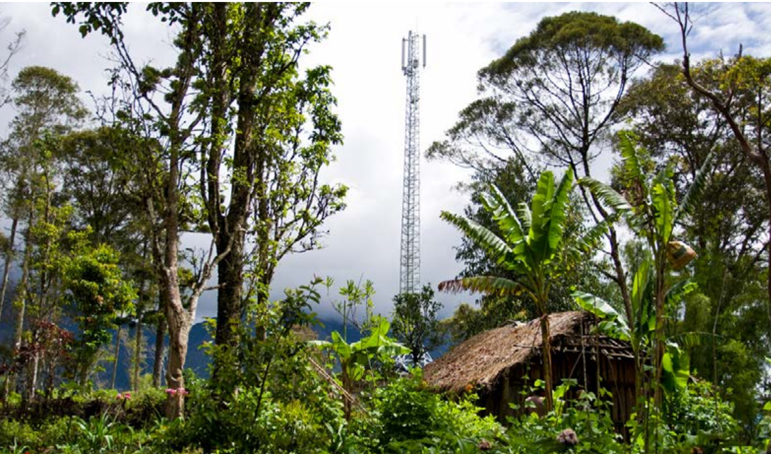
Un sistema di recente installazione sulle montagne della Papua Nuova Guinea consente la copertura della telefonia cellulare attraverso il ricorso a soluzioni di energia fotovoltaica.
